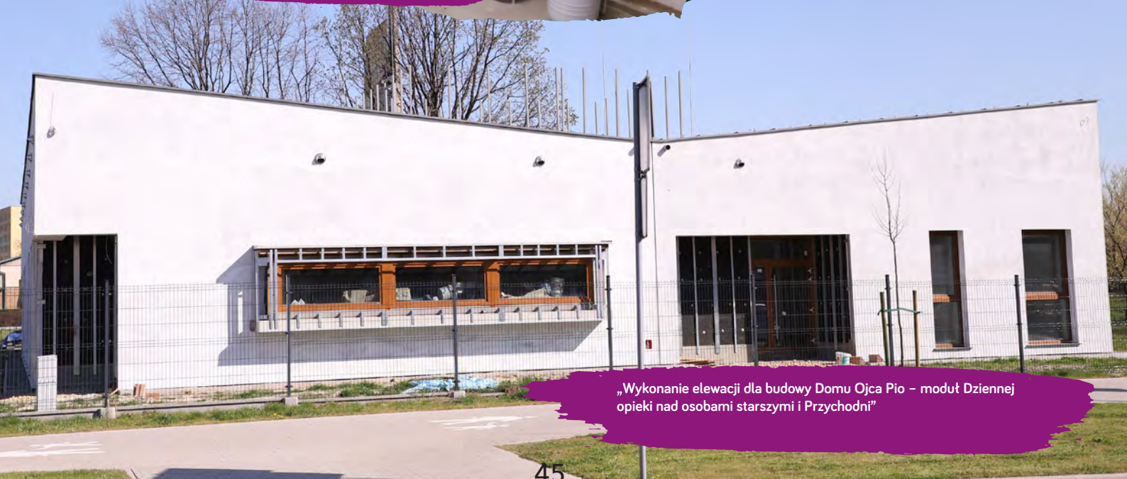
Modernizacja i przebudowa instalacji CO w budynku OSP Studzienice
